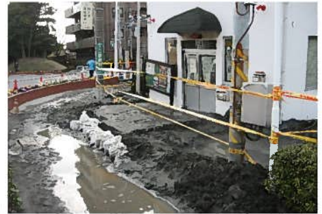
図 液状化による被害状況 (出典：災害写真データベース)
