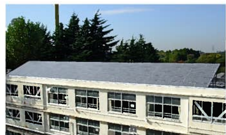
図 太陽光発電設備設置(西丸子小学校)
