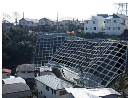
図 急傾斜地崩壊対策工事の事例
