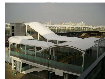
鹿島田こ線歩道橋
