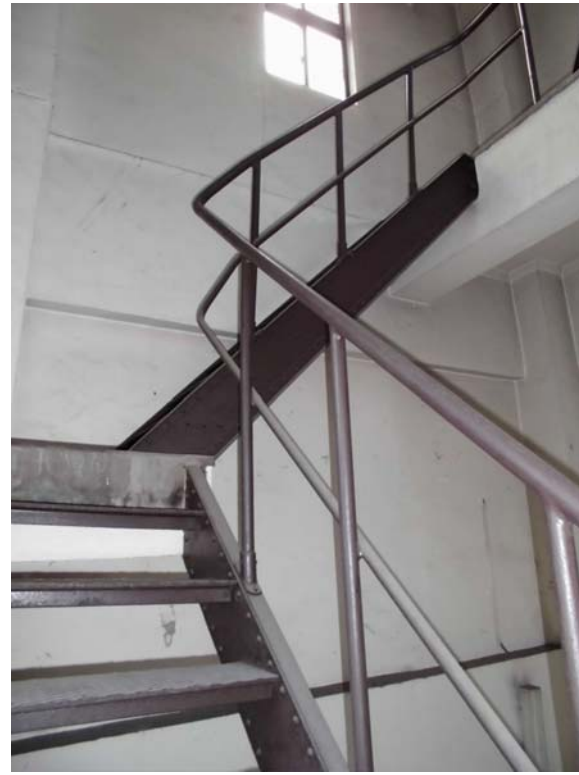
時計塔内部の鉄骨階段（4階より上部）
