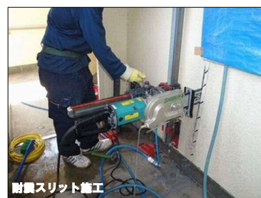
耐震スリット施工
