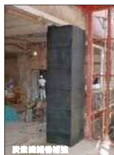
炭素繊維巻柱補強
