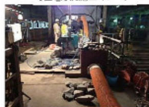
【写真②】杭打機・排泥管設置状況
