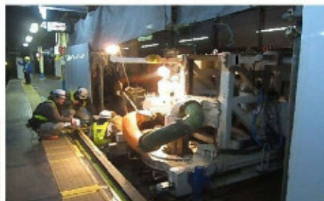
【写真①】ホーム上での杭施工状況(杭打機(掘削機))
