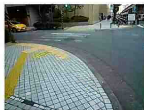
バリアフリー整備イメージ (歩道段差解消、視覚障害者誘導用ブロック敷設)
