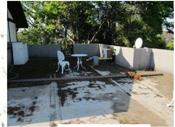
⑦ 事務室屋上
