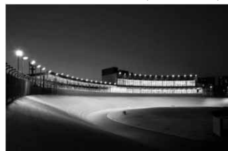
新しくなった川崎競輪場(西スタンド)
