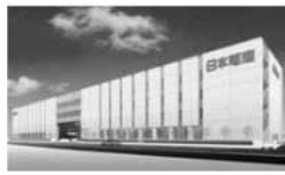
日本電産株式会社 中央モーター基礎技術研究所
