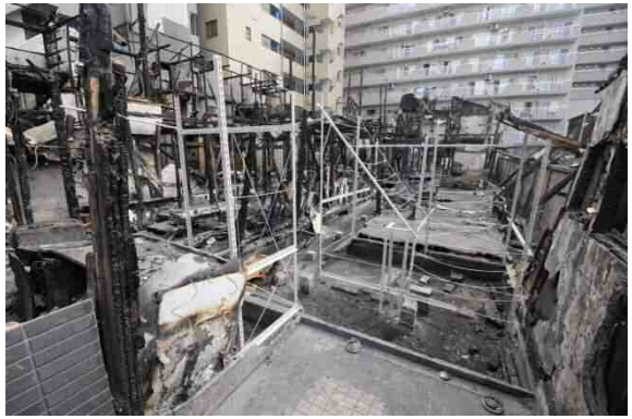
写真4 出火箇所の復元（1階ホール）
