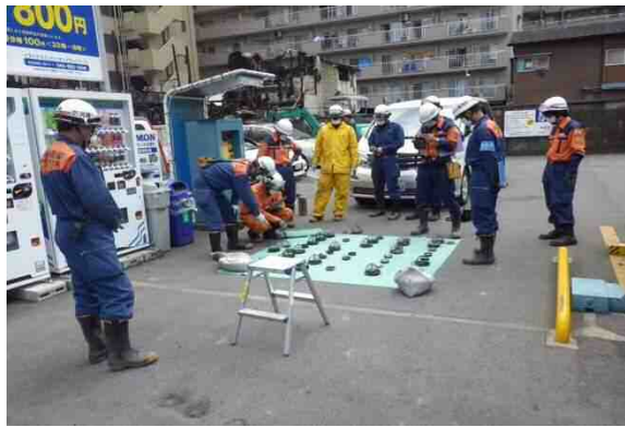
写真3 消防用設備の発掘（感知器）
