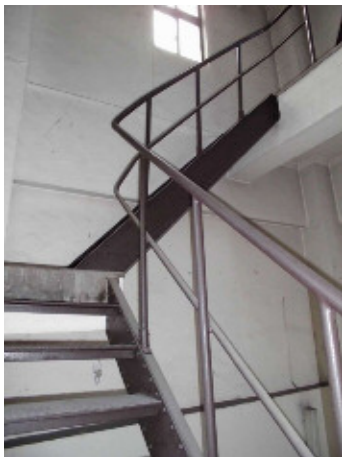
時計塔内部の鉄骨階段（4階より上部）
