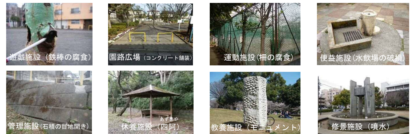
図4 施設の劣化状況及び現状
