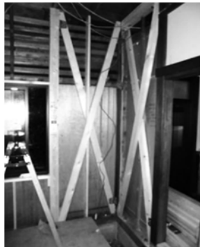
《木造住宅の耐震改修工事の様子》
