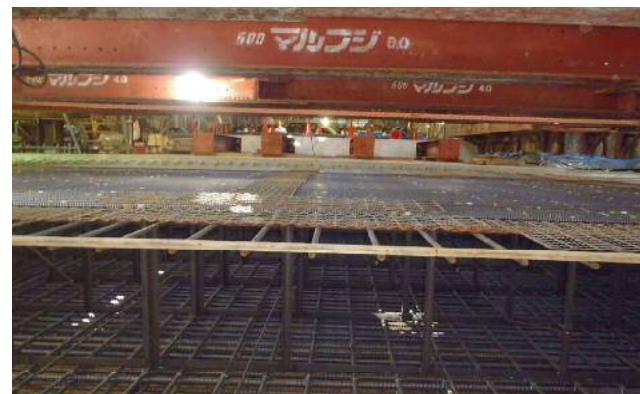
躯体構築工(駅部)
