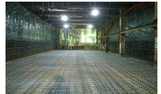
躯体構築工(箱型部)
