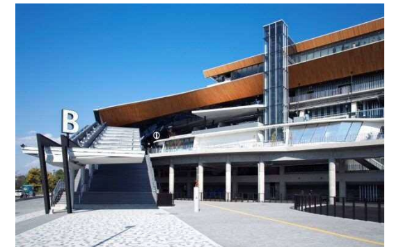
屋根が架かった幅の広いゲート
