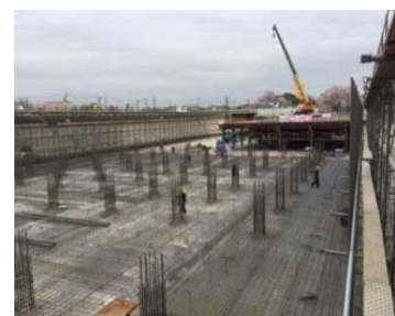
末吉配水池更新状況
