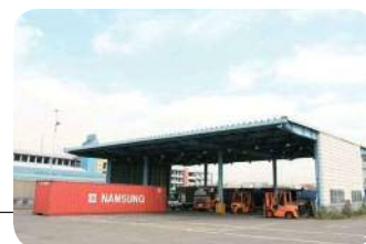
全天候型検査場 All-weather inspection Areas
