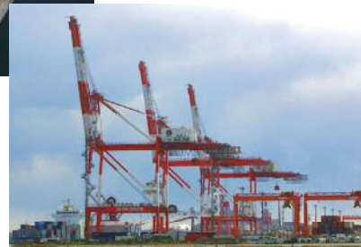
ガントリークレーン Gantry Crane
