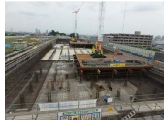
末吉配水池更新工事
