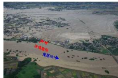
平成27年9月鬼怒川の被災状況（全景写真）
