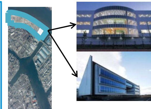
いすゞ自動車工場の跡地が最先端の研究拠点に
