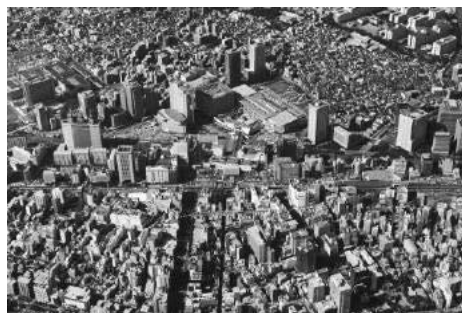
航空写真（川崎駅周辺地区）
