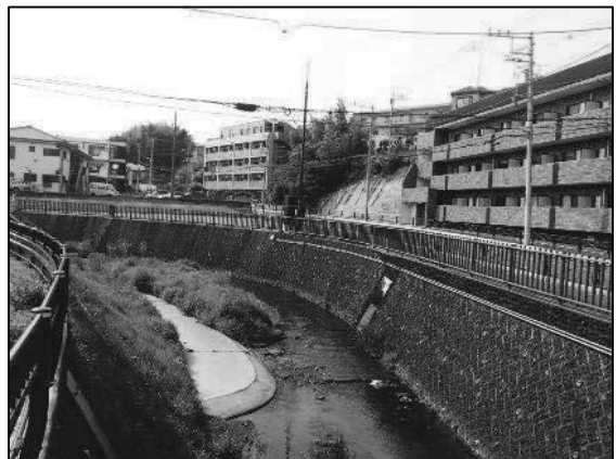
河川改修後の状況（平瀬川支川）
