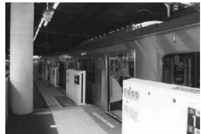
東急大井町線溝の口駅ホームドア
