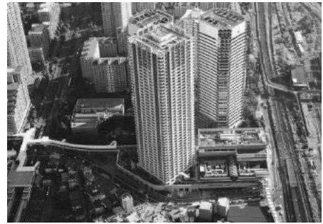
鹿島田駅西部地区市街地再開発事業
