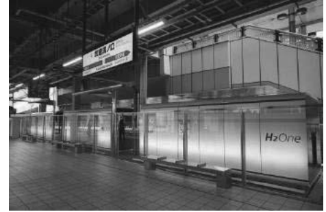
水素エネルギーの活用 (武蔵溝ノ口駅設置の「H2One™」)
