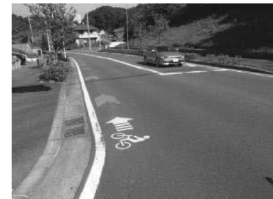
自転車通行位置を示す路面標示 (市道向ヶ丘遊園駅管生線)
