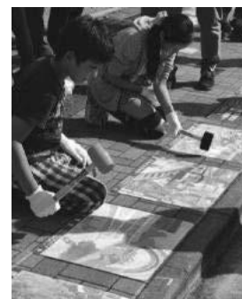
路面啓発シートの設置
