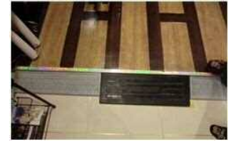
宿泊施設における段差解消ブロックによる段差解消事例
