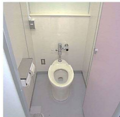
快適化された学校トイレ
