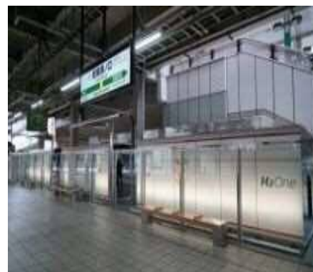
自立型水素エネルギー供給システム（JR武蔵溝ノ口駅）
