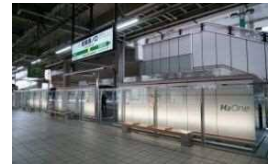
JR武蔵溝ノ口駅に導入された自立型水素エネルギー供給システム
