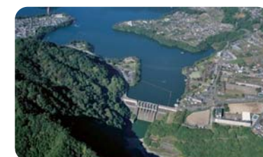
城山ダム 昭和40年に完成しました。神奈川県、横浜市、川崎市、横須賀市の共同事業である相模川総合開発事業として発電、水道用水、工業用水などを目的として建設されました。
