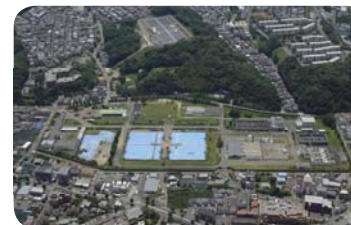
生田浄水場 昭和37年に通水を開始しました。処理方法は超高速凝集沈殿処理方式、施設能力は20万m 3 /日です。再構築計画により調整池などを建設しました。
