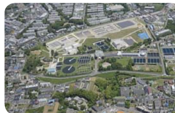
長沢浄水場 昭和29年6月に通水を開始しました。相模川を水源とし、処理方法は凝集沈殿処理方式、施設能力は25万m 3 /日です。再構築計画により調整池などを建設しました。
