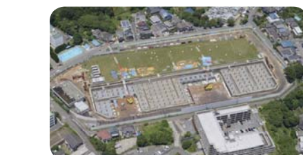
末吉配水池 昭和30年10月に完成した有効容量約7.2万m 3 の横浜市鶴見区に所在する配水池です。現在、更新工事を行っており、平成30年度に完了する予定です。
