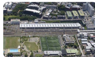
鷺沼配水池 昭和42年10月に完成した本市最大の配水池です。また上部を広場、フットサルコート、小学校校庭として利用しています。平成27年度に耐震補強工事が完了しており、有効容量は約11.0万m 3 です。
