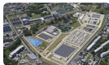
長沢浄水場 相模川を水源とし、昭和29年6月に通水を開始しました。また、再構築計画により浄水場全体を更新し、平成28年度から施設能力28万m 3 /日となりました。
