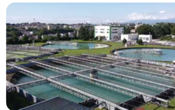
長沢調整池 再構築計画により建設し、平成22年度から本格運用を開始しています。
