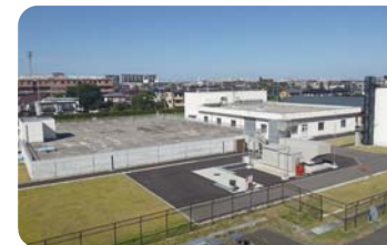
生田調整池 再構築計画により建設し、平成25年度から本格運用を開始しています。
