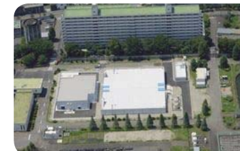
平間配水所 工業用水を使用する工場などが多く立地する臨海部への配水量や配水圧力を調整しています。再構築計画により調整池などの更新工事を行い、平成28年度から本格運用を開始しています。
