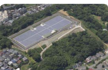
長沢浄水場 相模川を水源とし、昭和29年6月に通水を開始しました。また、再構築計画により浄水場全体を更新し、平成28年度から施設能力28万m 3 /日となりました。
