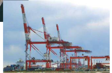
ガントリークレーン Gantry Crane
