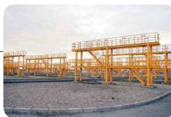
リーファー電源 Power points for a refrigerated container
