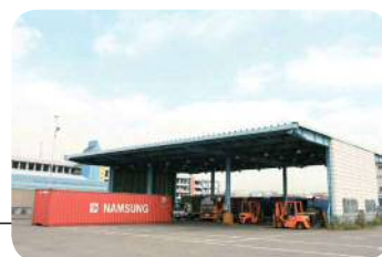
全天候型検査場 All-weather inspection Areas
