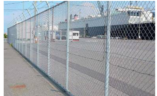
フェンスとゲート（東扇島外貿ふ頭）
