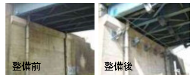
図 橋りょうの耐震化工事(小倉跨線橋)
