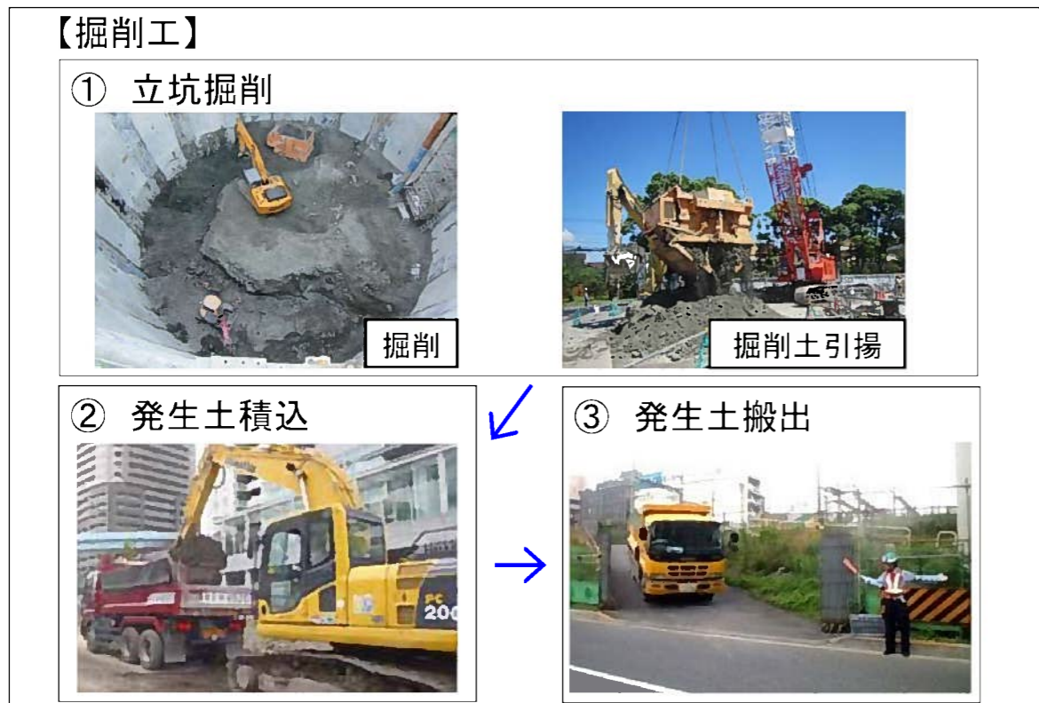
図 2-4(7) 掘削工の施工手順 (写真は類似工事の例)
