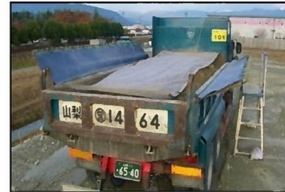
写真① 荷台への防じんシートの設置
