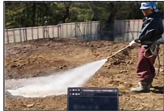
写真② 工事施工ヤード等の清掃、散水
