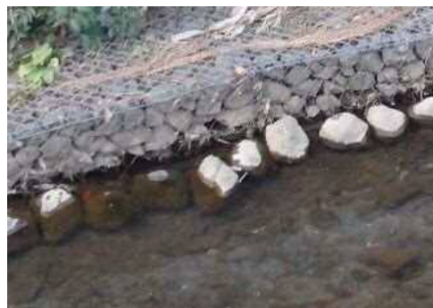
写真-6.2 捨石工(麻生川)
