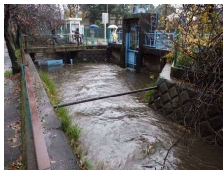
写真-5.6 出水状況(ニヶ領用水円筒分水 downstream、渋川分流部)
