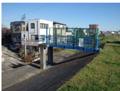
久地排水樋管(高津区)
