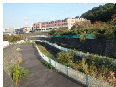
三沢川(麻生区)
