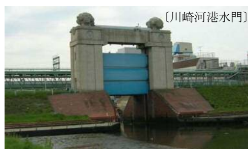
写真-1.3 川崎河港水門(供用約90年)
