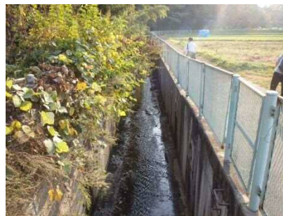
三沢川(麻生区)
