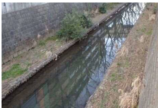
写真-6.1 かご工(麻生川)
