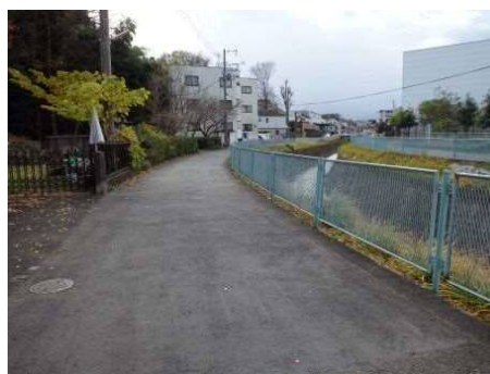
写真-6.5 河川管理用通路(平瀬川)
