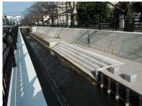
写真-6.7 渋川環境整備工事における階段工
