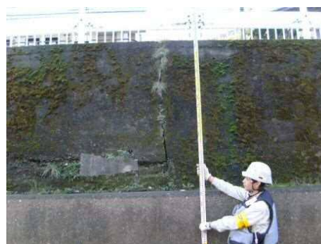
写真-5.4 詳細点検実施状況(二ヶ領本川)
