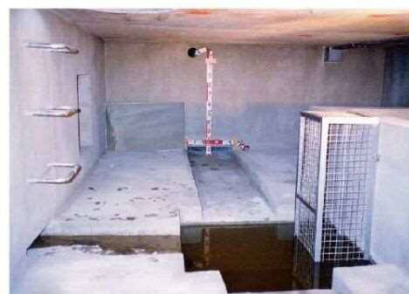
地下貯留槽内部
