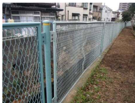
写真-6.12 転落防止柵破損状況
