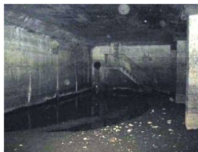
市制記念総合公園の駐車場地下 貯留施設内部(多摩区)
