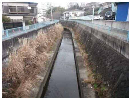
写真-6.9 河道内における植生繁茂状況
