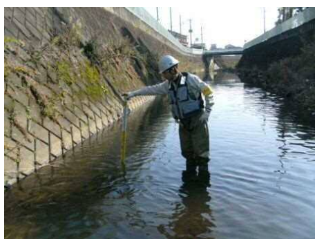
写真-5.3 詳細点検実施状況(平瀬川)
