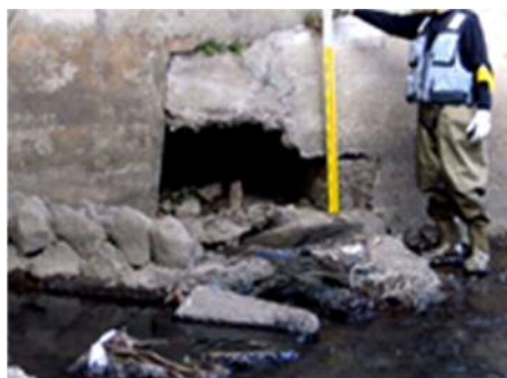
写真-1.8 老朽化による護岸背面の空洞
