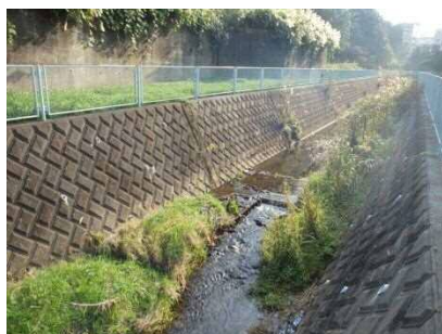
三沢川(麻生区)
