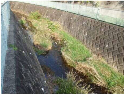
三沢川(麻生区)
