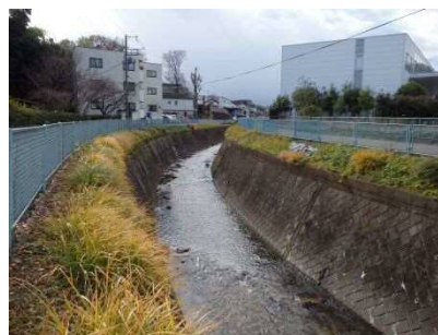
写真-5.1 平常時の河川状況(平瀬川)
