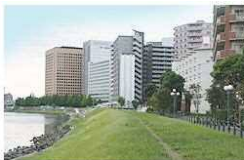
戸手地区の一部完成区域(幸区戸手)
