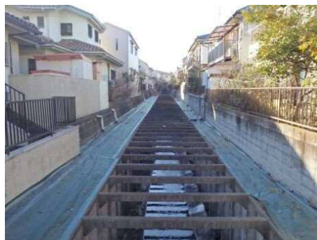
写真-6.10 防草シートの敷設(有馬川)
