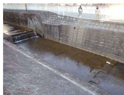
片平川の床止め(麻生区)
