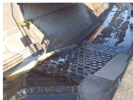
写真-6.3 魚道(平瀬川支川)
