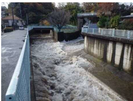
写真-5.5 出水状況(ニヶ領本川、平瀬川合流部)
