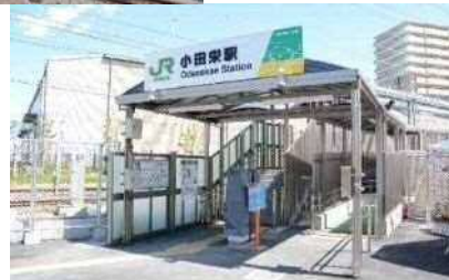
図 開業した JR 小田栄駅と増便された南武支線
