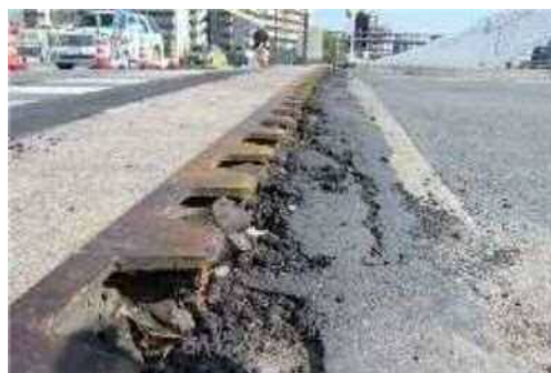
図 熊本地震により損傷し通行止めとなった橋梁（熊本停車場線 白川橋）
