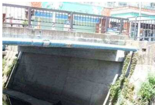
図 道路橋りょうの耐震化・橋台部分の縁端拡幅（宮前区山下橋）
