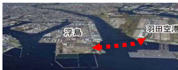
図 国道357号 多摩川トンネル区間
