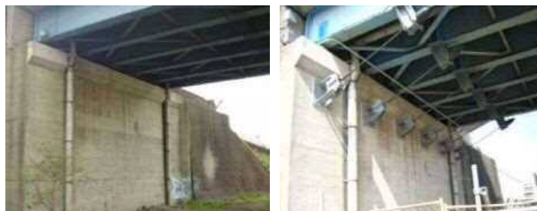
図 橋りよの耐震化工事(再掲)(小倉跨線橋) 左：整備前、右：整備後 出典：川崎市資料
