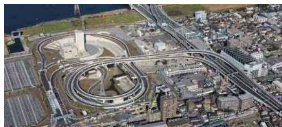
図 川崎縦貫道路（大師ジャンクション）
