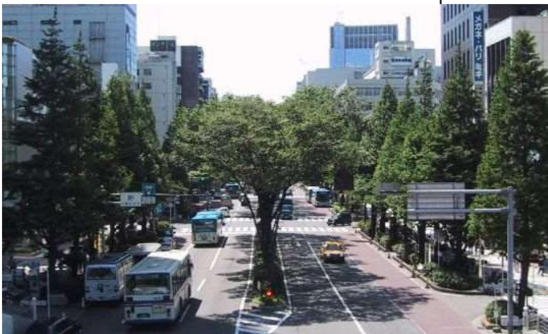
図 4-12 都市計画道路 川崎駅東扇島線
