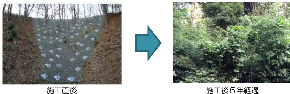
図 保全した樹林地の安全対策の例 (最小限の伐採で斜面安定を図るノンフレーム工法)
