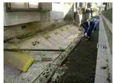
危険なブロック塀の倒壊例
