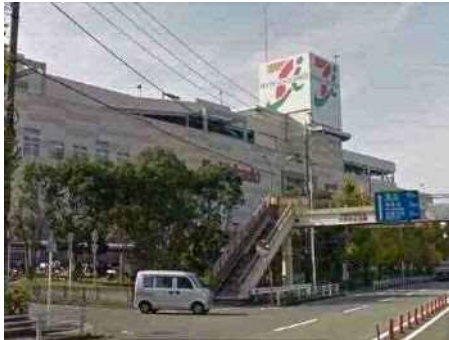
土地利用転換後の商業施設の様子
