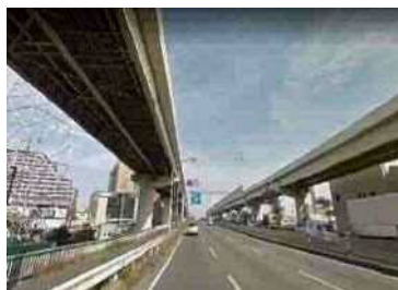
低騒音舗装の例
