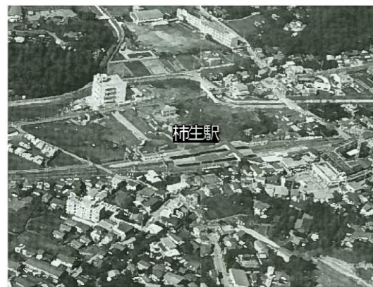
柿生駅周辺地区（昭和48年）
