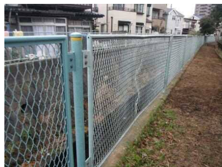
図 6.10 転落防止柵破損状況
