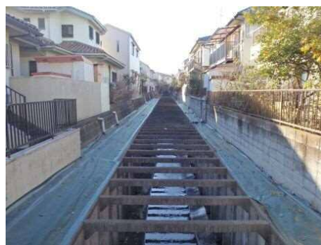
図 6.9 防草シートの敷設（有馬川）
