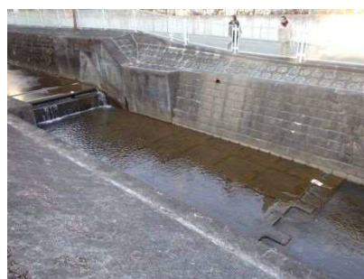
片平川の床止め（麻生区）
