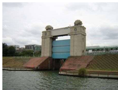
川崎河港水門（川崎区）
