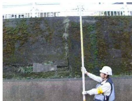
図 5.5 詳細点検実施状況（二ヶ領本川）
