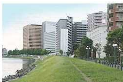
戸手地区の一部完成区域（幸区）
