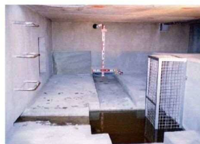
地下貯留槽内部
