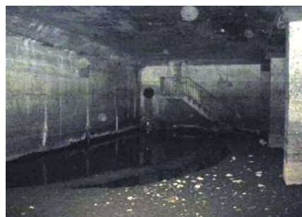
王禅寺ふるさと公園駐車場 地下貯留施設の内部（麻生区）
