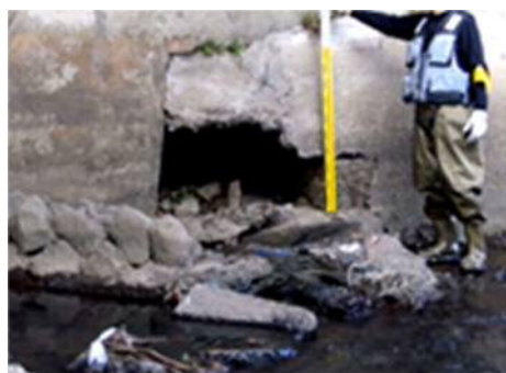
図 1.14 老朽化による護岸背面の空洞
