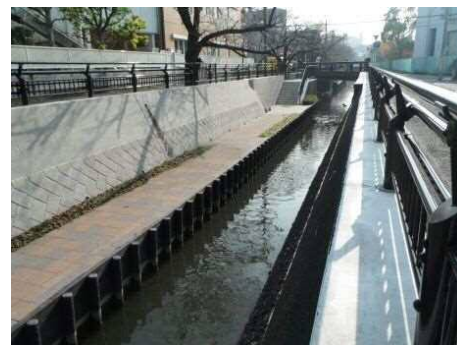
図 6.11 景観に配慮した転落防止柵（渋川）
