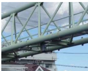
平瀬川下流テレメータ水位計（高津区）
