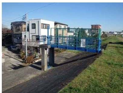
久地排水樋管（高津区）
