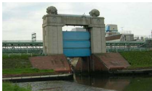
図 1.9 川崎河港水門(供用約 90 年)
