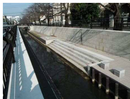
図 6.6 渋川環境整備工事における階段工
