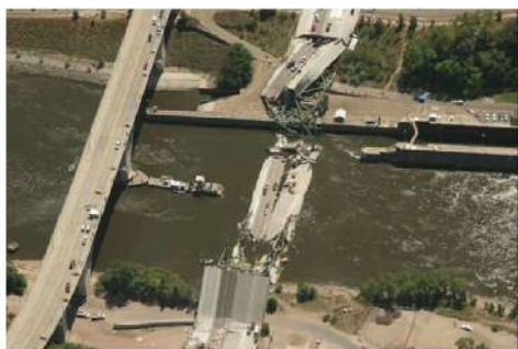
写真1 橋梁崩落事故の状況
