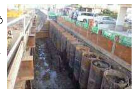
鋼管護岸へ更新中【市費にて対応】
