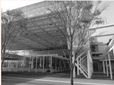
川崎駅東口駅前広場
