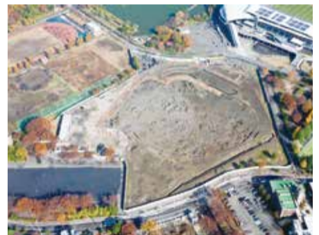
等々力硬式野球場工事現場
