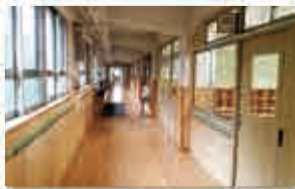
再生整備による内装改修
