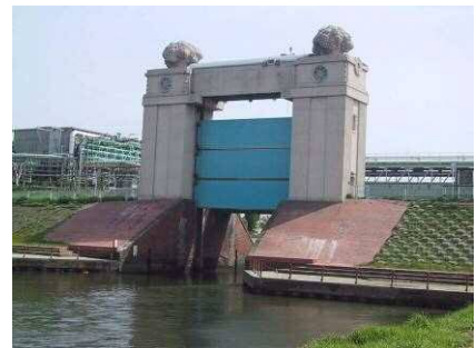
川崎河港水門
