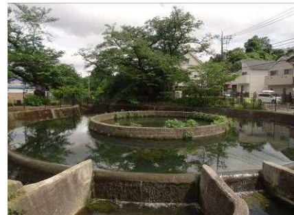
二ヶ領用水久地円筒分水
