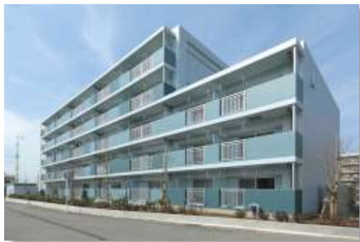
市営中野島住宅 新4号棟
