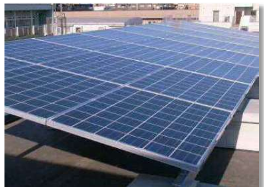
太陽光発電設備
