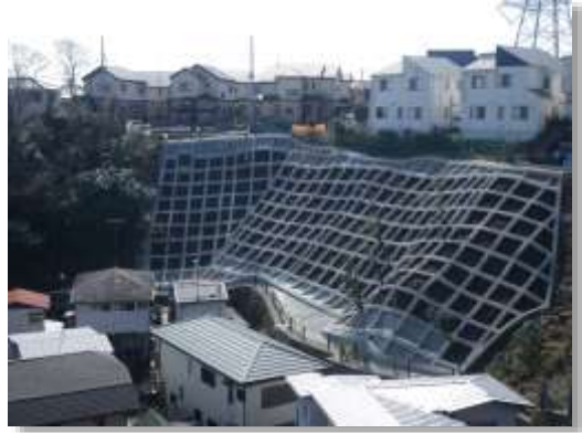
実施済み急傾斜地崩壊防止工事箇所
