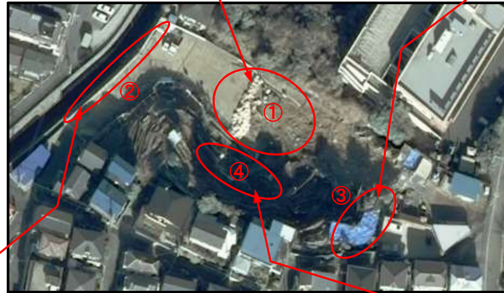
(出典：平成29年度川崎市航空写真、平成30年1月撮影)
