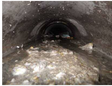
土砂流入による 公共下水道管の詰まり
