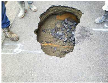
私道排水管の破損による 土砂流入・道路陥没
