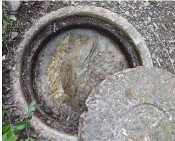
私道排水管の破損による ますの詰まり
