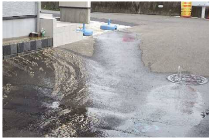
ますの詰まりによる 汚水の溢れ
