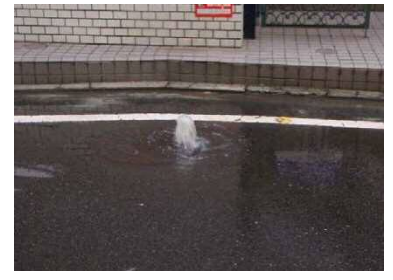
雨水などの混入による 溢水
