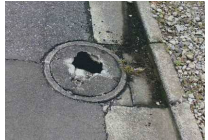
ますの破損による 雨水などの混入
